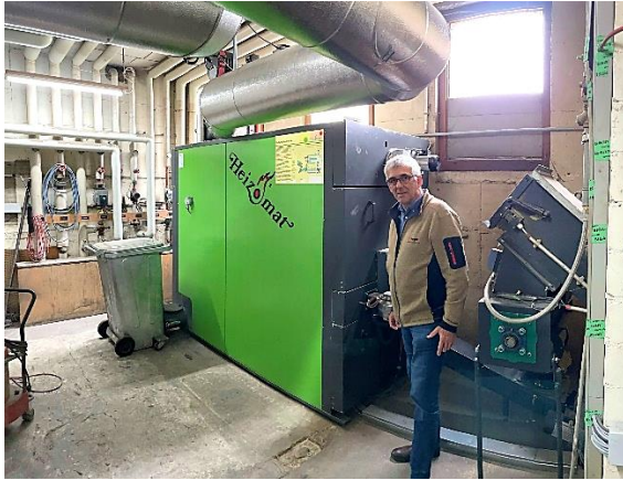
Heizomat AK200, Holzschnitzel-Heizkessel
