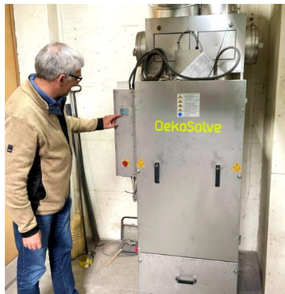
OekoRona 150, Elektro-Filteranlage mit mechanischer Abreinigung
